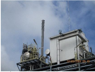
ภาพที่ 2.1-1 ปล่อง Reformer furnace
