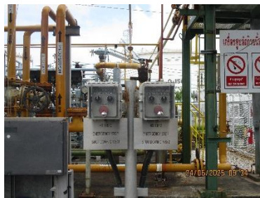
ภาพที่ 2.1-27 อุปกรณ์ตัดแยกระบบอัตโนมัติ
