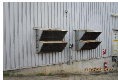
ภาพที่ 2.1-8 ติดตั้งอุปกรณ์ลดเสียง
